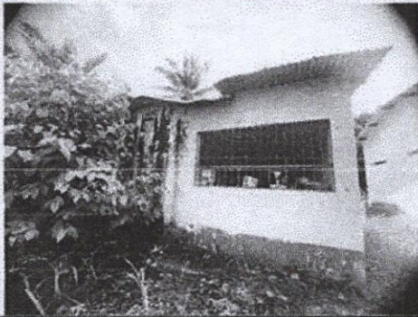
Foto1: Remozamiento de techo.
