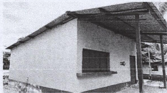
Foto 6: Reestructura del techo para realizarlo a dos aguas.
