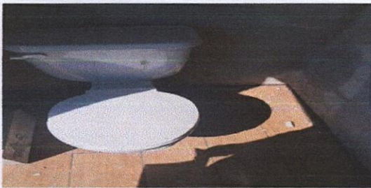
Foto 3: Sustitución de inodoros
