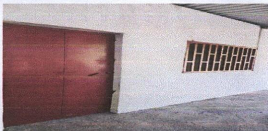
Foto 5: Sustitución de puertas de metal
