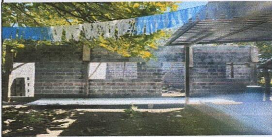
Foto1: Remozamiento de cocina
