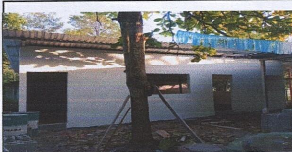
Foto 5: Sustitución de puertas de metal
