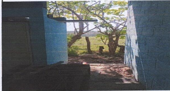
Foto 4: Sustitución de pila de dos lavaderos
