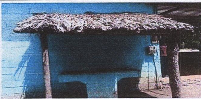
Foto 3: SUSTITUCIÓN DE PILA DE DOS LAVADEROS
