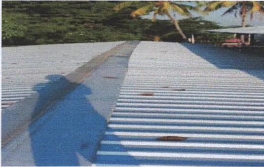
Foto 1: Instalación de lamina troquelada aluzin
