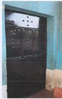
Foto 4: Sustitución de puerta
