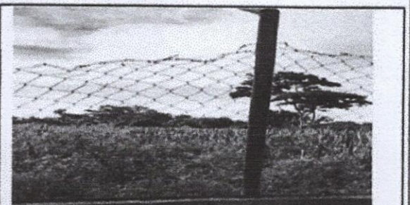
Foto 6: Sustrucción de barandas de metal
