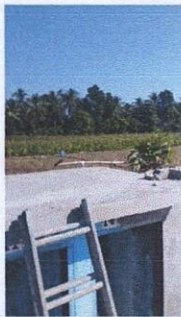
Foto 3: IMPERMEABILIZACIÓN DE LOSA
