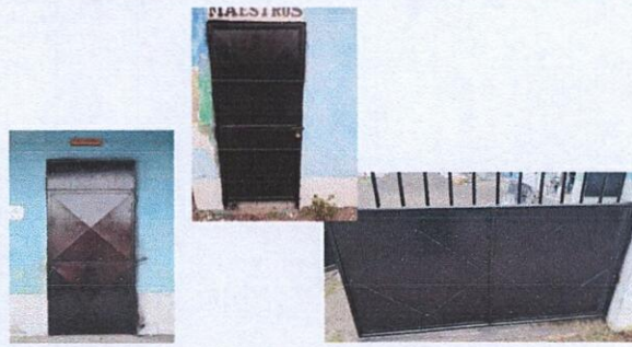
Foto 4: PUERTAS DE METAL: Mantenimiento a estructura (lijado, cambio de tubo, cepillado, sujeción, aplicación de pintura)
