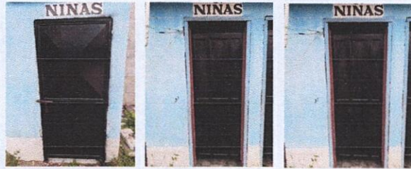
Foto 8: SERVICIOS SANITARIOS: Mantenimiento a estructura (lijado, cambio de tubo, cepillado, sujección, aplicación pintura) a puertas sanitarios
