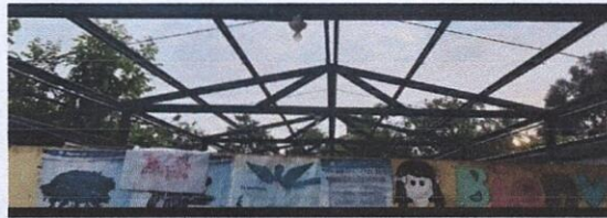
Foto 2: ESTRUCTURA DE TECHO: Sustitución de estructura de soporte
