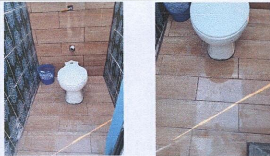
Foto 6: PISO: Sustitución de piso cerámico
