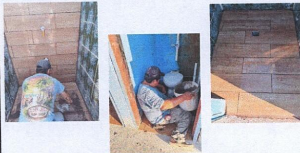
Foto 6: PISO: Sustitución de piso cerámico
