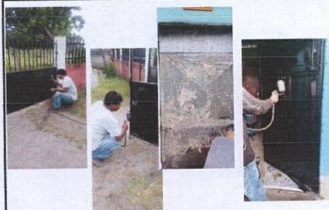
Foto 4: PUERTAS DE METAL: Mantenimiento a estructura (lijado, cambio de tubo, cepillado, sujeción, aplicación de pintura)
