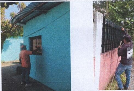
Foto 5: VENTANAS: Mantenimiento a estructura de metal de ventana
