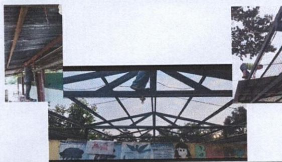
Foto 2: ESTRUCTURA DE TECHO: Sustitución de estructura de soporte
