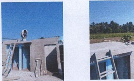
Foto 3: IMPERMEABILIZACIÓN DE LOSA
