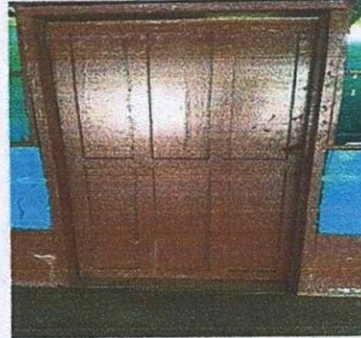
FOTO 2: SUSTITUCIÓN DE PUERTA DE MADERA
