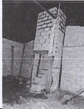
Foto 8: 20.2 Sustitución de estufa rural completa
