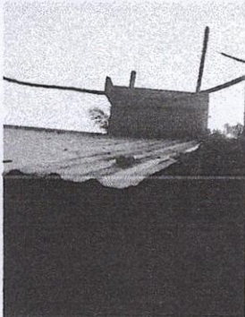
Foto 7: 18.2 Sustitución de deposito de agua 1100 lt
