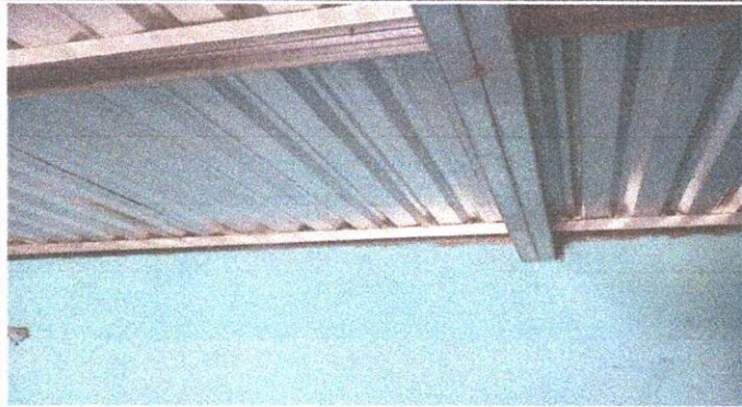
Foto1: CUBIERTA DE LAMINA. 1.1 Sustitucion de lamina, troquelada aluzinc calibre 26
