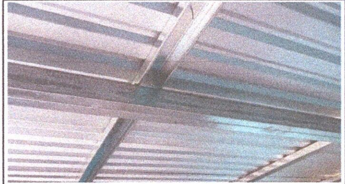
Foto 2: 2.3 ESTRUCTURA DE TECHO. Sustitucion de soporte de metal, por metal.
