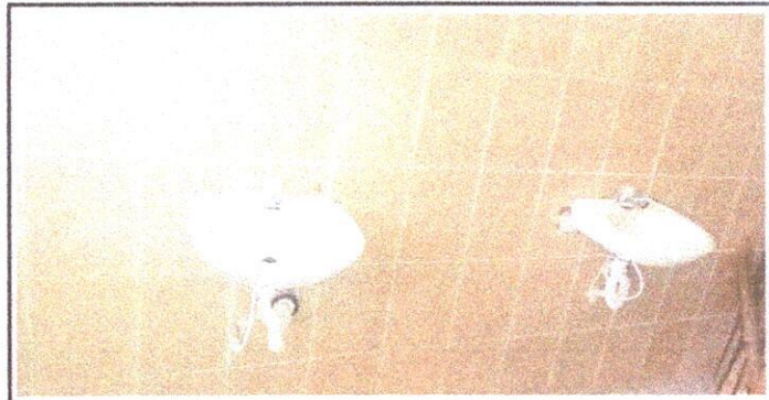
Foto 6: SERVICIOS SANITARIOS Y SUS ACCESORIOS. 10.5 Sustitucion de lavamanos
