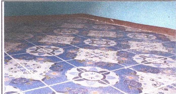
Foto 4: PISO. 6.5 Sustitucion de piso de torta de concreto
