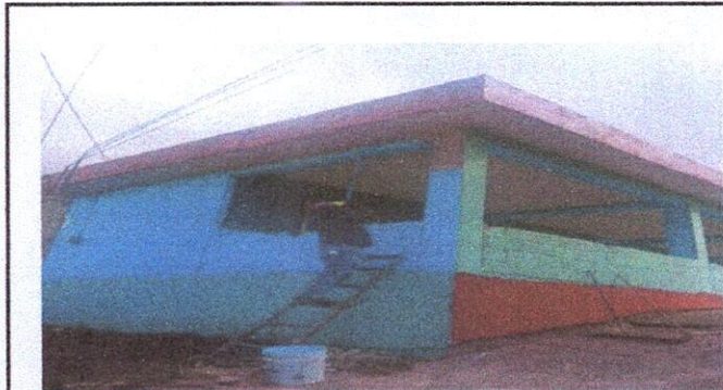
Foto 5: PINTURA EN MUROS EXTERIORES E INTERIORES. 9.1 Pintura en muros exteriores e interiores.
