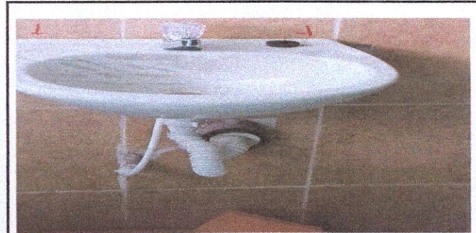
Foto 6: SERVICIOS SANITARIOS Y SUS ACCESORIOS. 10.5 Sustitucion de lavamanos
