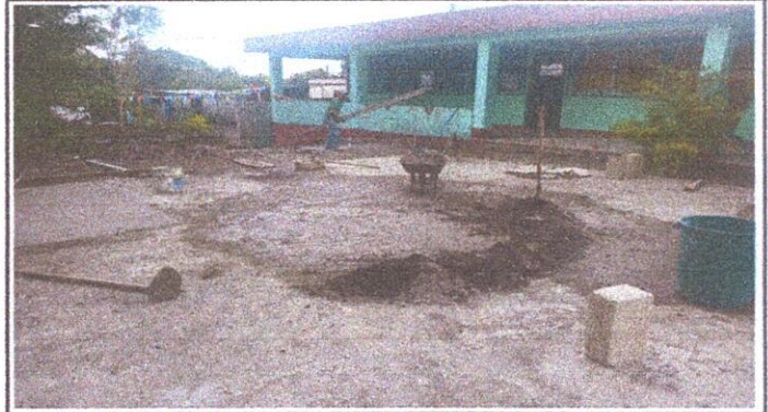
Foto 2: LOSA DE PATIO 16.1 Reparacion de planchas de concreto de patio
