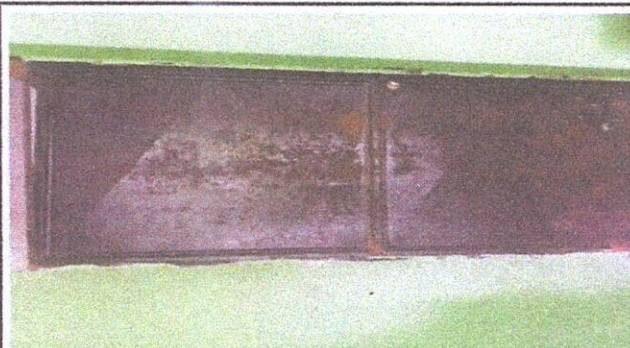
Foto 3: PUERTA DE METAL. 4.3 Sustitucion de puerta.
