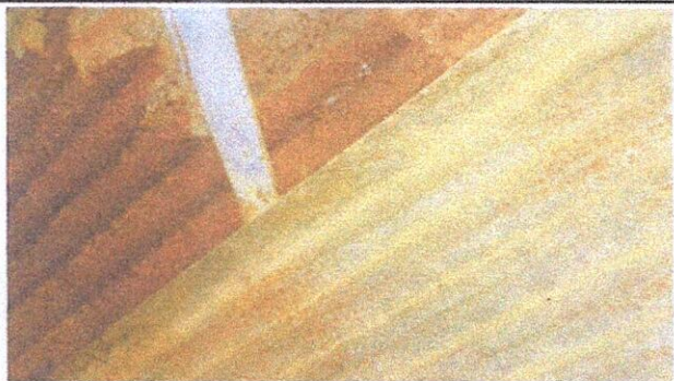
Foto1: CUBIERTA DE LAMINA. 1.1 Sustitucion de lamina, troquelada aluzinc calibre 26
