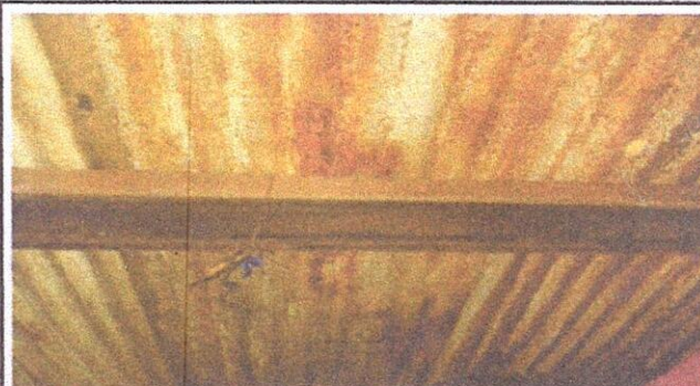
Foto 2: 2.3 ESTRUCTURA DE TECHO. Sustitucion de estructura de soporte de metal, por metal.
