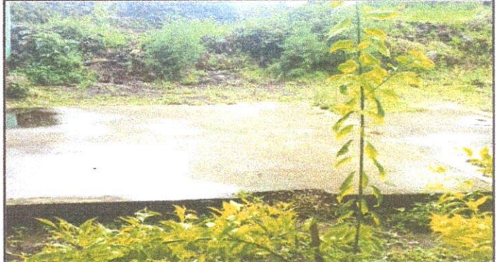
Foto 2: LOSA DE PATIO 16.1 Reparacion de planchas de concreto de patio
