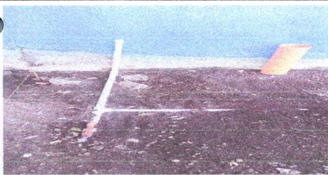
Foto 5: 7.3 Reparacion de bajada de agua pluvial, tubo pvc3"
