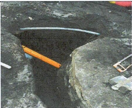
Foto 5: 7.3 Reparacion de bajada de agua pluvial, tubo pvc3"
