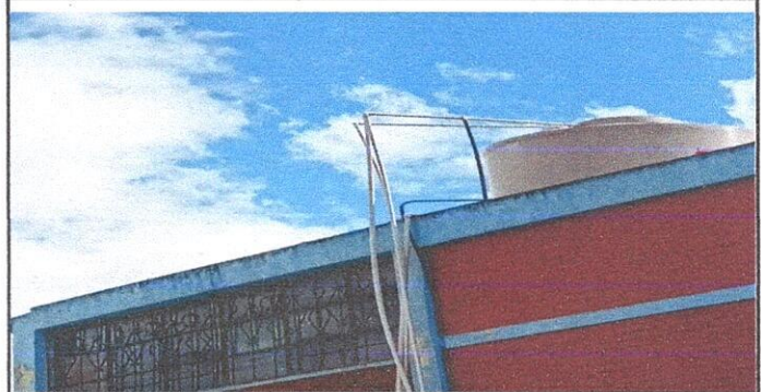
Foto 8: REPARACIÓN Y MANTENIMIENTO DE CISTERNAS/DEPOSITOS DE AGUA 18.3 Sustitución de depositos de agua
