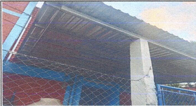
Foto 1: CUBIERTA DE LAMINA: 1.1 Sustitucion de lamina por lámina troquelada aluzink calibre 26
