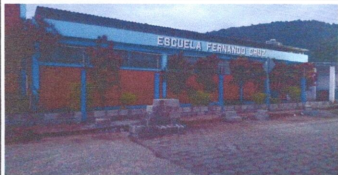
Foto 7: MUROS PERIMETRALES: 15.2 Reparación de muro perimetral de block con tubo y malla galvanizada, solera intermedia y columnas.
