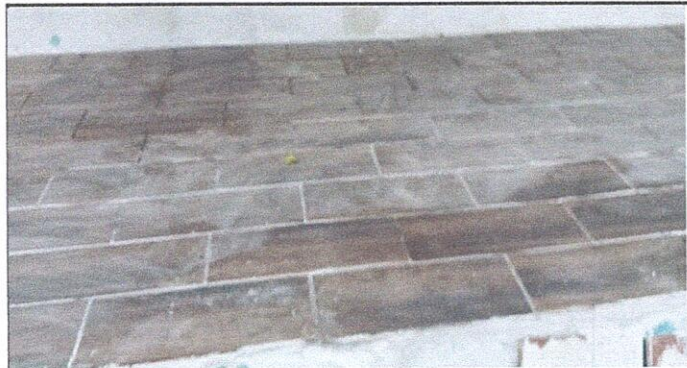
Foto 3: PISO: 6.5 Sustitución de piso de torta de concreto
