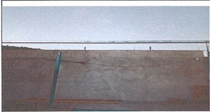
Foto 1 CUBIERTA DE LAMINA. 1.1 Sustitución de lamina por lámina troquelada aluzinc calibre 26
