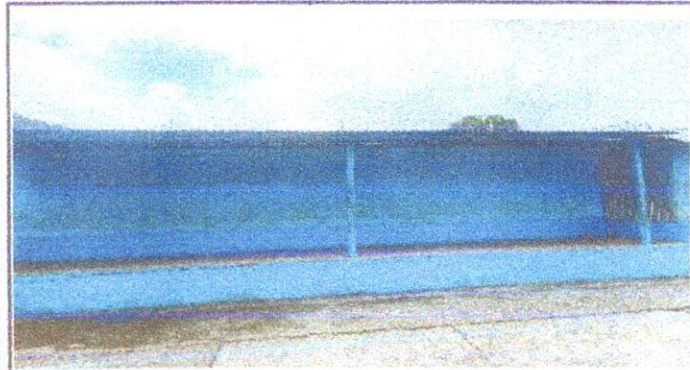
Foto 9: REPARACIÓN DE REPELLO Y CERNIDO DE PAREDES (CUANDO APLIQUE) 21.1 Repello en muro.
