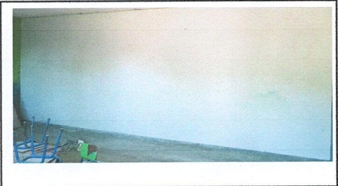
Foto 12: REPARACION DE REPELLO Y CERNIDO DE PAREDES. 21.1 Repello de muro
