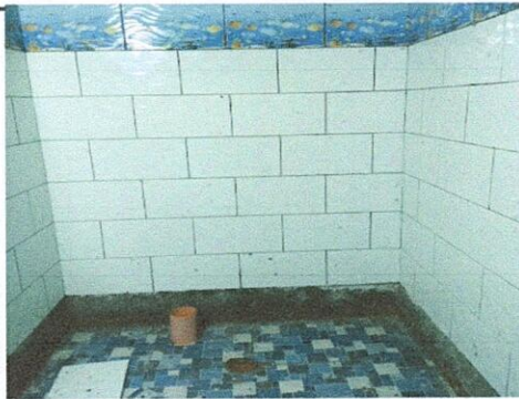
Foto 08: SUSTITUCION DE AZULEJO. 13.1 Sustitución de azulejo
