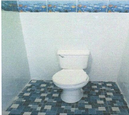
Foto 06: SERVICIOS SANITARIOS. 10.3 Sustitución de inodoro
