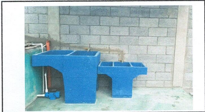
Foto 13. INSTALACION DE PILA. 19.2 Instacion de pila
