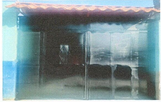
Foto 07: MANTENIMIENTO A PORTONES 12.1 Mantenimiento a portones de metal
