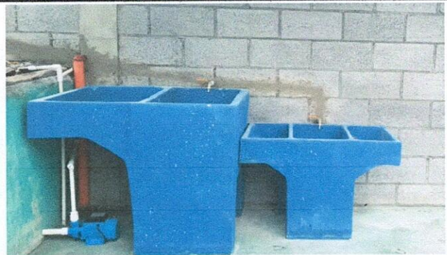
Foto 09. REPARACION DE RED DE DRENAJE Y RED DE AGUA POTABLE. 14.13 Sustitución de llave de chorro
