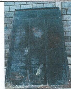
Foto 10: SERVICIOS SANITARIOS 10.1 Mantenimiento a estructura (lijado, cepillado, aplicación de pintura) a puerta servicios sanitario
