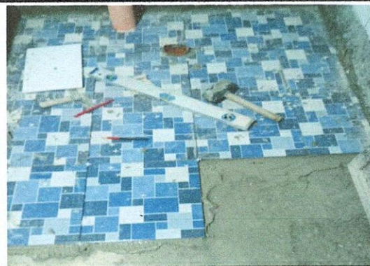
Foto 4: PISO 6.7 sustitución de piso de granito
