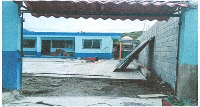
Foto 07: MANTENIMIENTO A PORTONES 12.1 Mantenimiento a portones de metral
