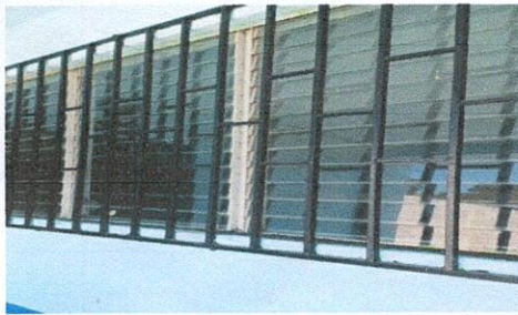
Foto 3: VENTANAS 5.1 mantenimiento estructura de metal de ventana
