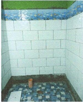
Foto 06: SERVICIOS SANITARIOS. 10.3 Sustitución de inodoro
