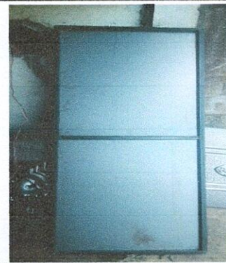
Foto 2: 4.4 Sustitución de puerta en servicio sanitario
