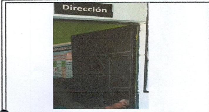
Foto 11: MANO DE OBRA ESPECIALIZADA. 19.4 Frabricacion e instalacion de puertas de metal en baños
