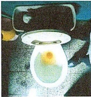
Foto 06: SERVICIOS SANITARIOS Y SUS ACCESORIOS. 10.3 Sustitucion de inodoro.
