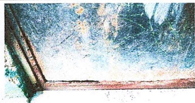
Foto 10. SERVICIOS SANITARIOS. 10.1 Mantenimiento a estructura ( lijado, cepillado, aplicación de pintura) a puerta servicios sanitarios.
