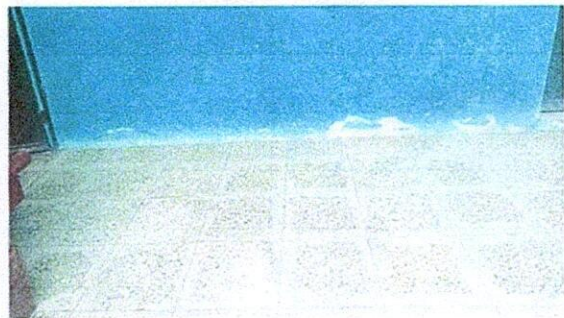
Foto 4: PISO 6.7 sustitucion de piso de granito.
