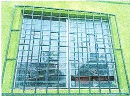
Foto 3: VENTANAS 5.1 mantenimiento estructura de metal de ventana.
