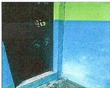
Foto 11: MANO DE OBRA ESPECIALIZADA. 19.4 Fabricacion e instalacion de puertas de metal en baños.
