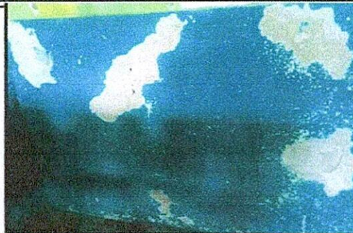
Foto 12; REPARACION DE REPELLO Y CERNIDO DE PAREDE. 21.1 Repello de muro.
