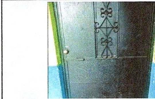
Foto 1: PUERTAS DE METAL 4.1. Mantenimiento a estructura (lijado, cambio de tubo, cepillado, sujetaciones, aplicación de pintura)
