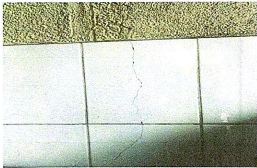
Foto 08: SUSTITUCION DE AZULEJO. 13.1 Sustitucion de azulejo.
