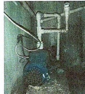
Foto 11: REPACION Y MANTENIMIENTO DE CISTERNAS Y DEPOSITO DE AGUA. 18.3 Sustitucion de bomba de agua.
