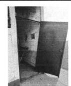
Foto 9: LA PUERTA ESTÁ DAÑADA DEBIDO A QUE LOS SUJETADORES ESTÁN EN MAL ESTADO Y PRESENTAN ÓXIDO.
