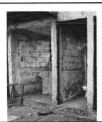
Foto 12: HUMEDAD EN PAREDES DE SANITARIOS, PINTURA EN MAL ESTADDO, NO TIENE PUERTA
