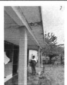
Foto 3: EL MÓDULO DE AULAS PRESENTA HUMEDAD EN LOSA Y NO TIENE BAJADAS DE AGUA PLUVIAL
