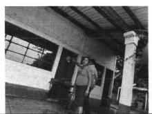
Foto 11: ESTRUCTURA METALICA CON OXIDO, ANCLAJE DE LAMINAS MALOS, PUERTA CON OXIDO
