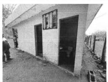
Foto 7: MÓDULO DE AULAS, SANITARIOS EN MAL ESTADO, PUERTAS CON OXIDO, HUMEDAD EN LOSA
