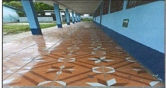
Foto 2: 6 PISO 6.8 Sustitución de piso cerámico
