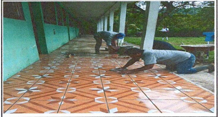
Foto 2: 6 PISO 6.8 Sustitución de piso cerámico
