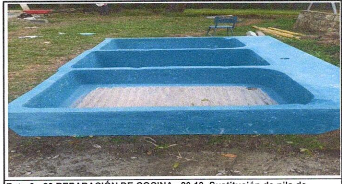
Foto 6: 20 REPARACIÓN DE COCINA 20.10 Sustitución de pila de cemento de dos lavaderos
