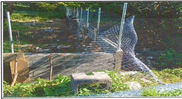
Foto 5: 15 MUROS PERIMETRALES 15.2 Reparación de muro perimetral de block con tubo hg y maya galvanizada soleras intermedias y columnas.
