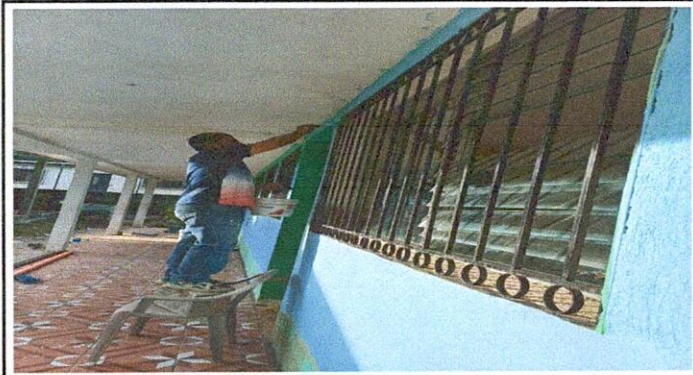
Foto 3: 9 PINTURA EN MUROS EXTERIORES E INTERIORES 9.1 Pintura en muros exteriores e interiores.
