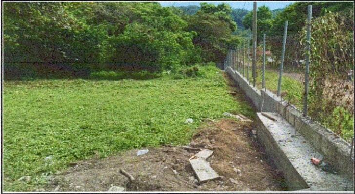
Foto1: REPARACION DE REPELLO Y CERNIDO DE PAREDES (CUANDO APLIQUE) 21.1 repello en muros
