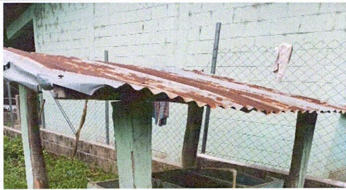
Foto 1: 1 CUBIERTA DE LAMINA 1.1 Sustitución de lámina, por lamina troquelada. 1.3 sustitución de elementos de fijación.
