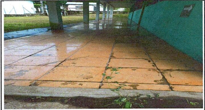
Foto 2: 6 PISO 6.8 Sustitución de piso cerámico
