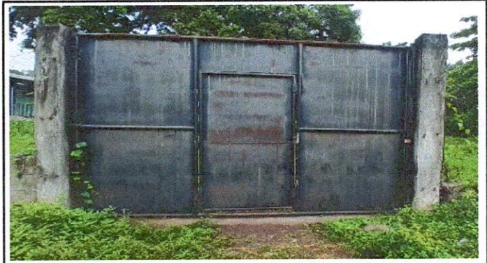
Foto 4: 12 MANTENIMIENTO A PORTONES 12.1 Mantenimiento a portones de metal.
