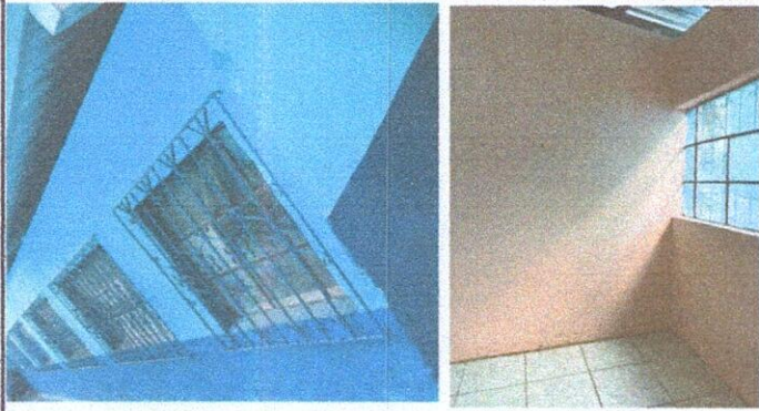
Foto 14: 21. REPARACIÓN DE REPELLO Y CERNIDO DE PAREDES. 21.2 Cernido en muro.
