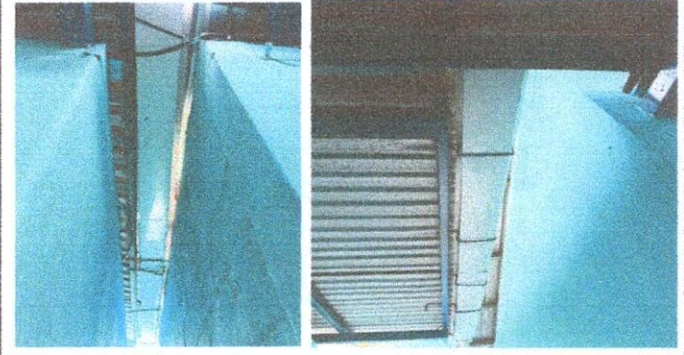
Foto 6: 7. CANALES Y BAJADAS DE AGUA. 7.1 Sustitución de canal de metal, 7.2 Sustitución de canal de pvc, 7.5 Sustitución de soporte o pescante de metal para canal.
