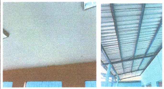
Foto 2: 2. Estructura de techo. 2.1 Mantenimiento a estructura de soporte de metal.
