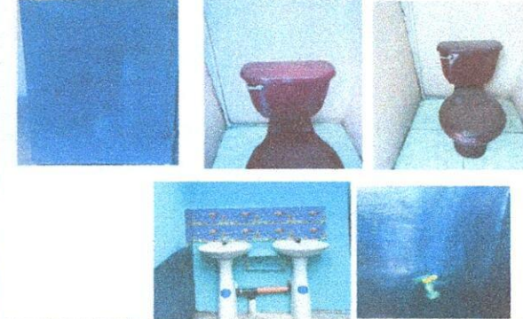
Foto 8: 10. SERVICIOS SANITARIOS Y ACCESORIOS. 10.1 Mantenimiento a estructura (lijado, cambio de tubo, cepillado, sujeciones, aplicación de pintura) a puertas servicios sanitarios, 10.2 Sustitución accesorio de Inodora (contra llave, tubo de abasto y tanque), 10.4 Sustitución de mezcladora lavamanos (contra llave, tubo de abasto), 10.6 Sustitución de llave en migratorio, 10.11 Sustitución de tapadera sanitario
