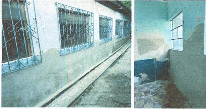
Foto 14: 21. REPARACIÓN DE REPELLO Y CERNIDO DE PAREDES. 21.2 Cernido en muro.
