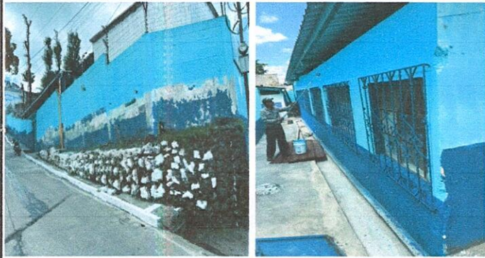
Foto7: PINTURA EN MUROS EXTERIORES E INTERIORES. 9.1 Pintura en muros exteriores e interiores,
