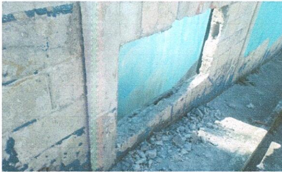
Foto 9: 15. MUROS PERIMETRALES. 15.1 Reparación muro perimetral de block.
