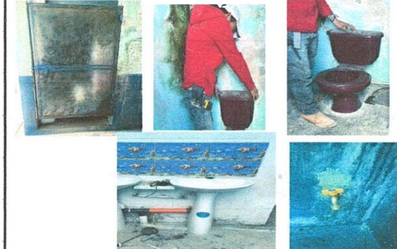
Foto 8: 10. SERVICIOS SANITARIOS Y ACCESORIOS. 10.1 Mantenimiento a estructura (lijado, cambio de tubo, cepillado, sujeciones, aplicación de pintura) a puertas servicios sanitarios, 10.2 Sustitución accesorio de Inodora (contra llave, tubo de abasto y tanque), 10.4 Sustitución de mezcladora lavamanos (contra llave, tubo de abasto), 10.6Sustitución de llave en migratorio, 10,11 Sustitución de tapadera sanitario
