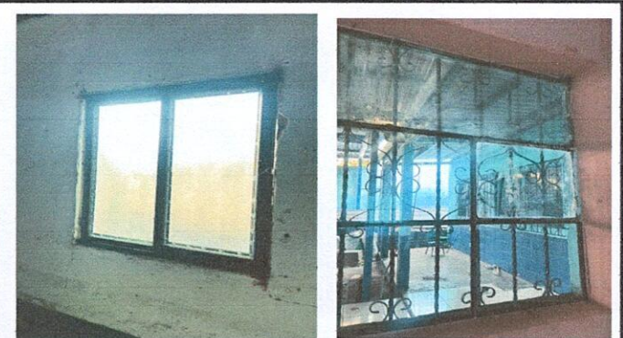
Foto 4: 5. Ventana. 5.3 Sustitución de ventana de madera por metal más vidrio, 5.5 Sustitución de Vidrios, 5.7 Mantenimiento de balcones de metal.
