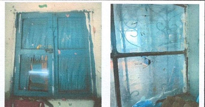
Foto 4: 5. Ventana. 5.3 Sustitución de ventana de madera por metal más vidrio, 5.5 Sustitución de Vidrios, 5.7 Mantenimiento de balcones de metal.
