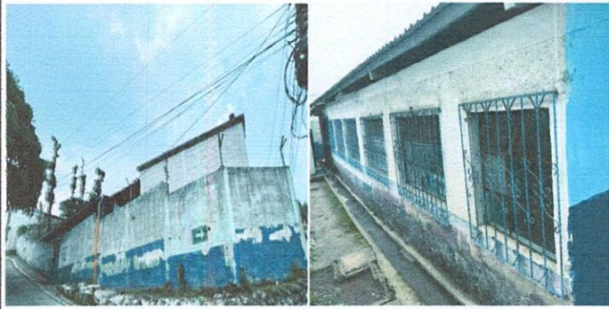
Foto7: PINTURA EN MUROS EXTERIORES E INTERIORES. 9.1 Pintura en muros exteriores e interiores,
