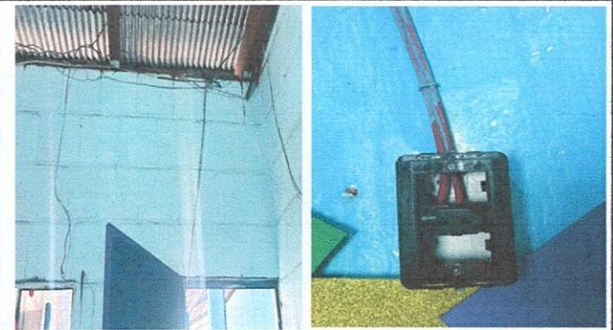
Foto 10: 17. REPARACIÓN DE SISTEMA ELECTRICO. 17.6 Sustitución de interruptores simples, 17.8 Sustitución de tomacorrientes dobles, 17.11 Reparación de cableado eléctrico, 17.12 Sustitución de ducto eléctrico+accesorios
