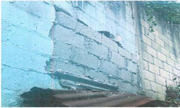
Foto 9: 15. MUROS PERIMETRALES. 15.1 Reparación muro perimetral de block.
