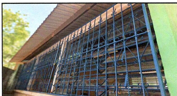
Foto 4: 5 VENTANAS: 5.6 Sustitución de balcones de metal.
