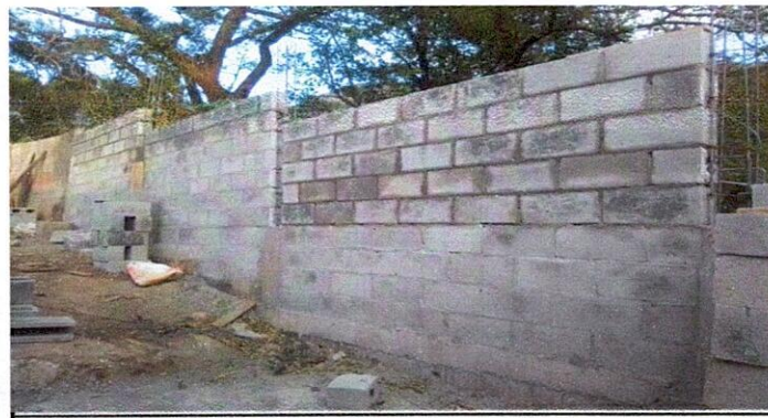
Foto 6: 15 MUROS PERIMETRALES: 15.1 Reparación de muro perimetral de block.
