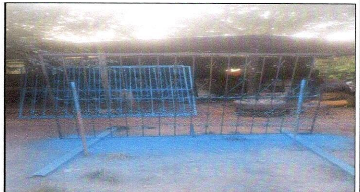
Foto 4: 5 VENTANAS: 5.6 Sustitución de balcones de metal.
