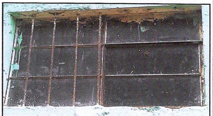
Foto 4: 5 VENTANAS: 5.6 Sustitución de balcones de metal.
