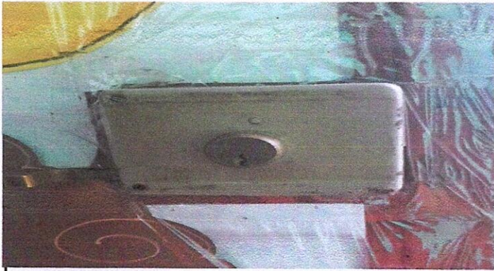
Foto 1: 4 PUERTAS DE METAL: 4.2 Sustitución de chapas
