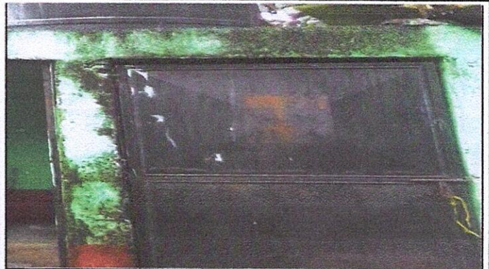
Foto 2: 4 PUERTAS DE METAL: 4.4 Sustitución de puertas en servicios sanitarios
