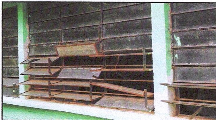
Foto 3: 5 VENTANAS: 5.1 Mantenimiento a estructura de metal de ventana, 5.2 sustitución de estructura de metal de ventana
