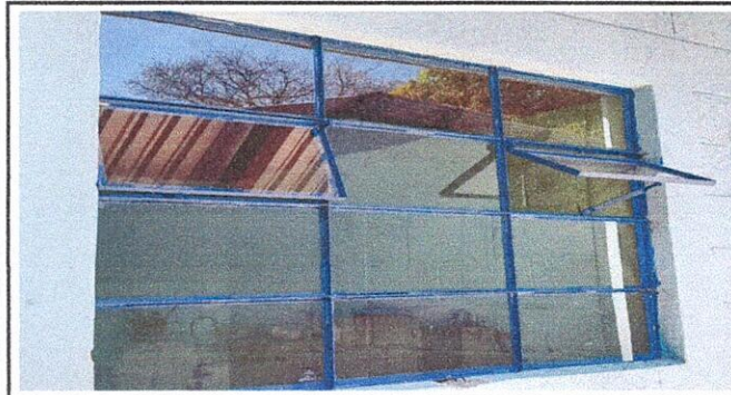
Foto 3: VENTANAS 5.5 Sustitución de vidrios.
