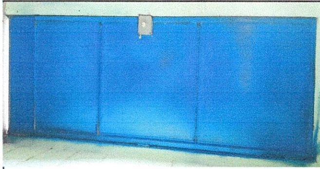
Foto1: PUERTAS DE METAL 4.1 Mantenimiento a estructura. 4.2 Sustitución de chapa.
