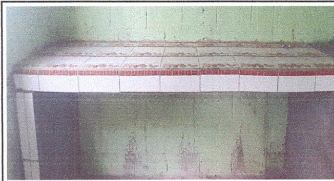
Foto 9: REPARACIÓN DE COCINA 20.8 Reparación de azulejo en muebles de cocina.
