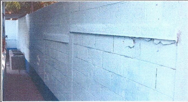
Foto 7: MUROS PERIMETRALES 15.1 Reparación de muro perimetral de block.
