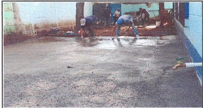
Foto 4: PISO 6.5 Sustitución de piso de torta de concreto
