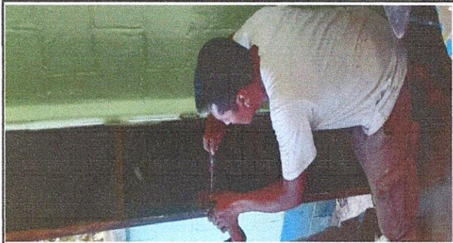
Foto1: PUERTAS DE METAL 4.1 Mantenimiento a estructura. 4.2 Sustitución de chapa.
