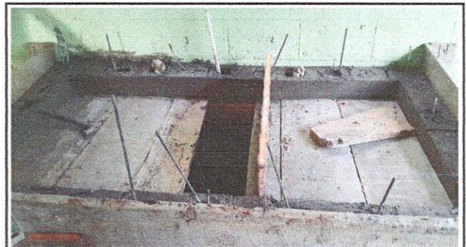
Foto 10: REPARACIÓN DE COCINA 20.10 Sustitución de pila de cemento de dos lavaderos.
