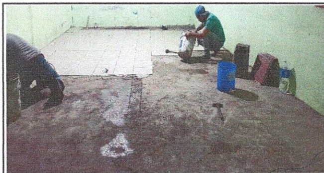
Foto 5: PISO 6.8 Sustitución de piso cerámico
