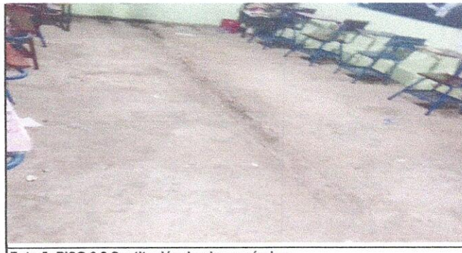
Foto 5: PISO 6.8 Sustitución de piso cerámico
