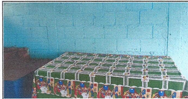
Foto 9: REPARACIÓN DE COCINA 20.8 Reparación de azulejo en muebles de cocina.
