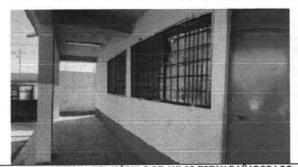
Foto 12: LA VENTANA DEL MÓDULO DE AULAS ESTAN DAÑADOS LOS VIDRIOS Y EL BALCON ESTA DAÑADO CON OXIDO
