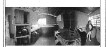
Foto 3: MÓDULO DE COCINA CHIMENEA DAÑADA, PUERTAS EN MAL ESTADO, NO CUENTAN CON BALCON LAS VENTANAS, PLANCHAS METALICAS EN MAL ESTADO, FUGA EN LA PILA
