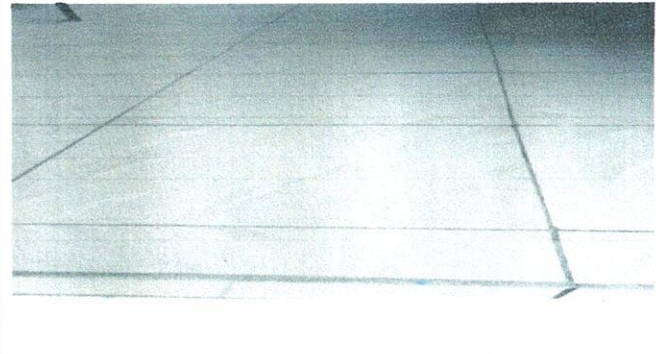
Foto 4: 6. PISO. 6.5 Sustitución de torta de concreto
