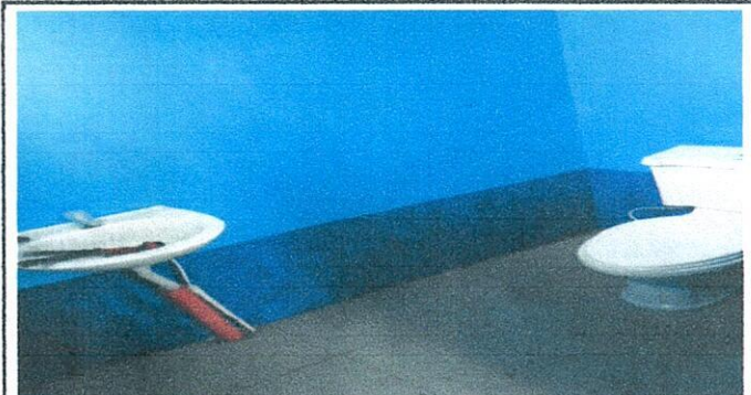
Foto 6: 10. SERVICIOS SANITARIOS Y SUS ACCESORIOS. 10.3 Sustitución de inodoro. 10.5 Sustitución de lavamanos.
