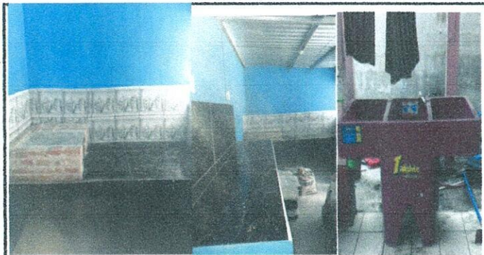
Foto 5: 20 REPARACIÓN DE COCINA 20.2 Sustitución de estufa rural (completa) incluye chimenea y plancha de metal. 20.7 instalación de azulejo en estufa rural. 20.12 Sustitución de pila plástica de dos
