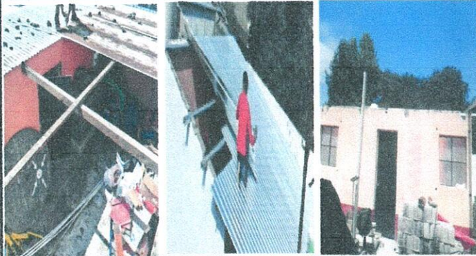
Foto1: CUBIERTA DE LÁMINA 1.1 Sustitución de lámina por lámina troquelada aluzinc calibre 26. 1.3 sustitución de elementos de fijación. 2.1 Sustitución de estructura de soporte de madera por metal.
