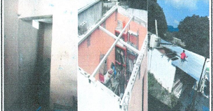
Foto 2: 19 MANO DE OBRA ESPECIALIZADA (ALBAÑILERÍA, HERRERÍA, ELECTRICIDAD Y PLOMERÍA) 19.4 Fabricación e instalación de puertas de metal en baños. 19.7 Instalación de estructura portante de metal. 19.8
