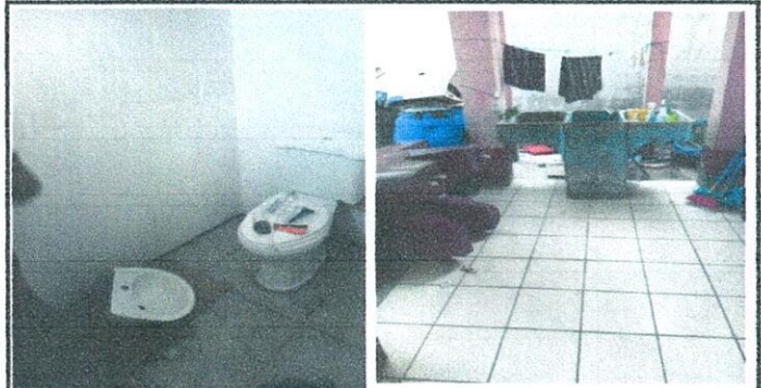
Foto 4: 19 MANO DE OBRA ESPECIALIZADA (ALBAÑILERÍA, HERRERÍA, ELECTRICIDAD Y PLOMERÍA) 19.15 instalación de inodoro. 19.17 Instalación de lavamanos. 19.20 Instalación de pila.
