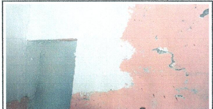
Foto 6: 21 REPARACION DE REPELLO Y CERNIDO DE PAREDES (CUANDO APLIQUE) 21.1 Repello en muro 21.2 Cernido en muro.
