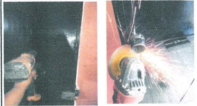
Foto 2: 4.PUERTAS DE METAL. 4.1 Mantenimiento a estructura (cepillado y aplicación de pintura). 4.2 Sustitución de chapa
