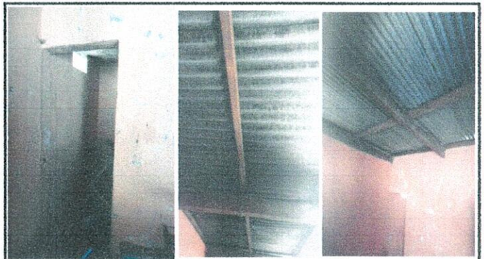
Foto 2: 19 MANO DE OBRA ESPECIALIZADA (ALBAÑILERÍA, HERRERÍA, ELECTRICIDAD Y PLOMERÍA) 19.4 Fabricación e instalación de puertas de metal en baños. 19.7 Instalación de estructura portante de metal. 19.8
