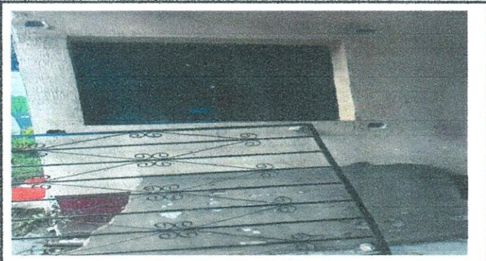
Foto 3: 5 VENTANAS 5.7 Mantenimiento a balcones de metal
