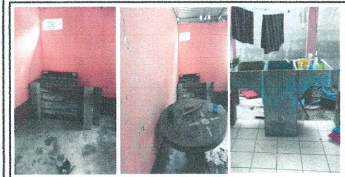
Foto 5: 20 REPARACIÓN DE COCINA 20.2 Sustitución de estufa rural (completa) incluye chimenea y plancha de metal. 20.7 instalación de azulejo en estufa rural. 20.12 Sustitución de pila plástica de dos lavaderos.
