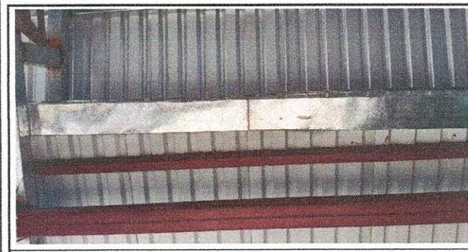
Foto 5: CANALES Y BAJADAS DE AGUA PLUVIAL 7.1 Sustitución de canal de metal.
