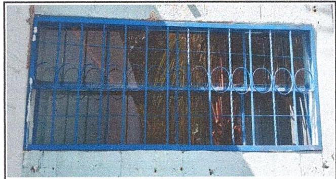
Foto 4: VENTANAS 5.6 Sustitución de balcones de metal.
