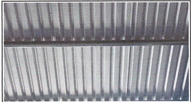
Foto 2: CUBIERTA DE LÁMINA 1.3 Sustitución de elementos de fijación.
