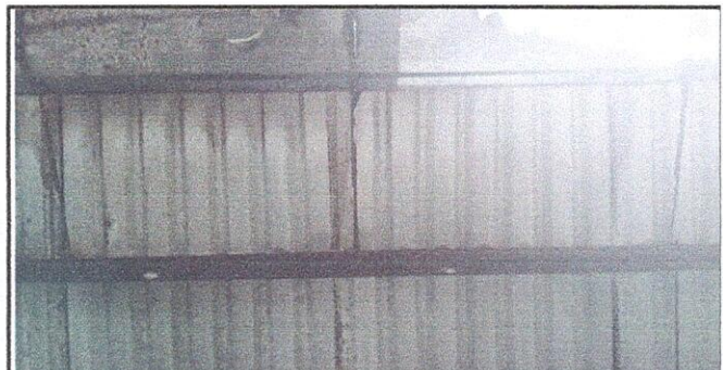
Foto 6: CANALES Y BAJADAS DE AGUA PLUVIAL 7.5 Sustitución de soporte o pescante de metal para canal.
