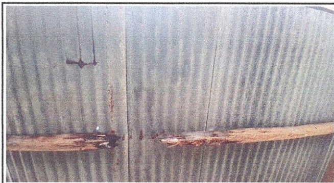
Foto 3: ESTRUCTURA DE TECHO 2.2 Sustitución de soporte de madera, por metal.
