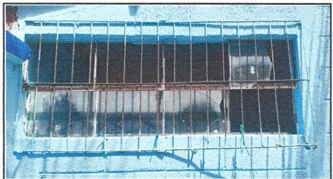
Foto 4: VENTANAS 5.6 Sustitución de balcones de metal.
