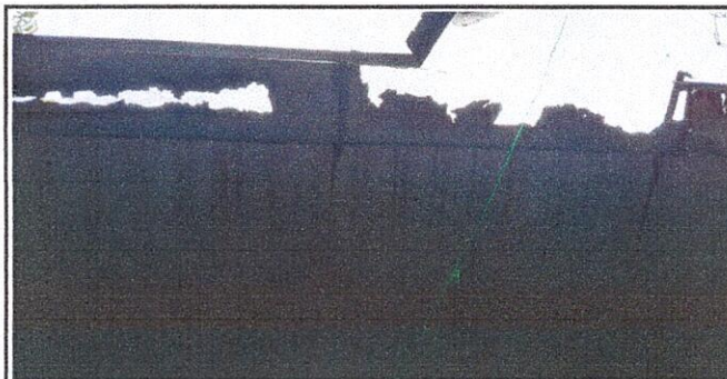
Foto 5: CANALES Y BAJADAS DE AGUA PLUVIAL 7.1 Sustitución de canal de metal.
