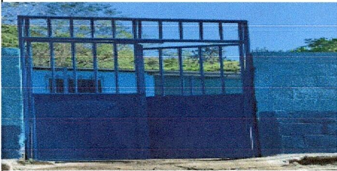
Foto 1: MANTENIMIENTO A PORTONES 12.1 Mantenimiento a portón de metal
