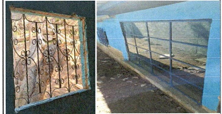
Foto 4: VENTANAS 5.1 Mantenimiento a estructura de metal de ventana 5.5 Sustitución de vidrios.
