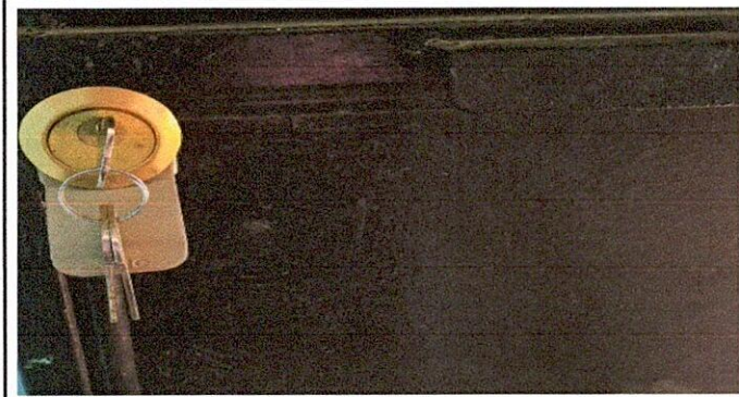
Foto 3: PUERTAS DE METAL 4.1 Mantenimiento a estructura (lijado, cambio de tubo, cepillado, sujeciones, aplicación de pintura) 4.2 Sustitución de chapa 4.3 Sustitución de Puerta.
