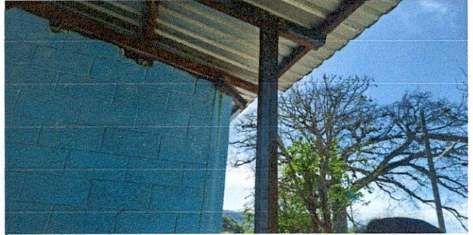
Fotos 2: ESTRUCTURA DE TECHO 2.1 Mantenimiento a estructura de soporte de metal
