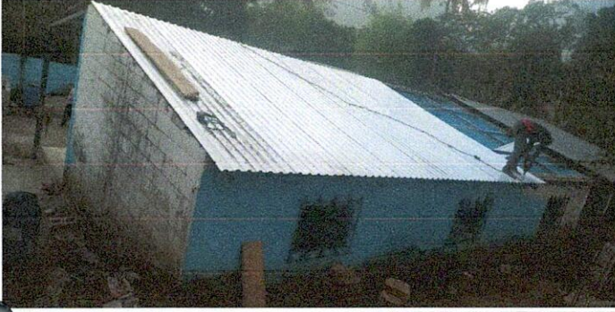
Foto 1: CUBIERTA DE LÁMINA 1.1 Sustitución de lámina, por lámina troquelada aluzinc calibre 26. 1.3 Sustitución de elementos de fijación
