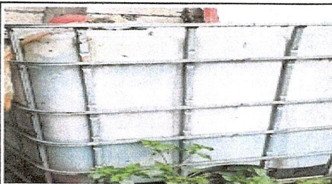
Foto 3: REPARACIÓN Y MANTENIMIENTO DE CISTERNAS / DEPÓSITO DE AGUA 18.2 Sustitución de depósito de agua 1100 lt
