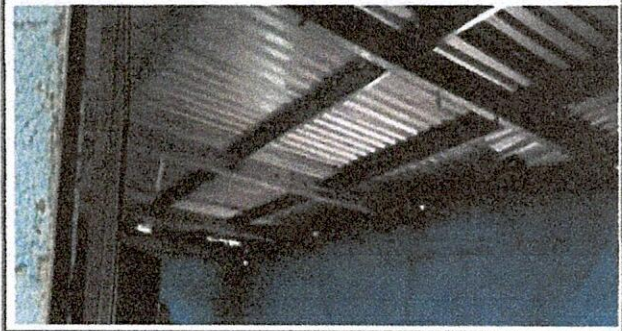
Fotos 2: ESTRUCTURA DE TECHO 2.1 Mantenimiento a estructura de soporte de metal
