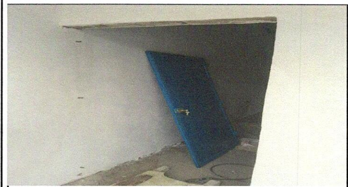
Foto 3: PUERTAS DE METAL 4.3 Sustitución de puerta
