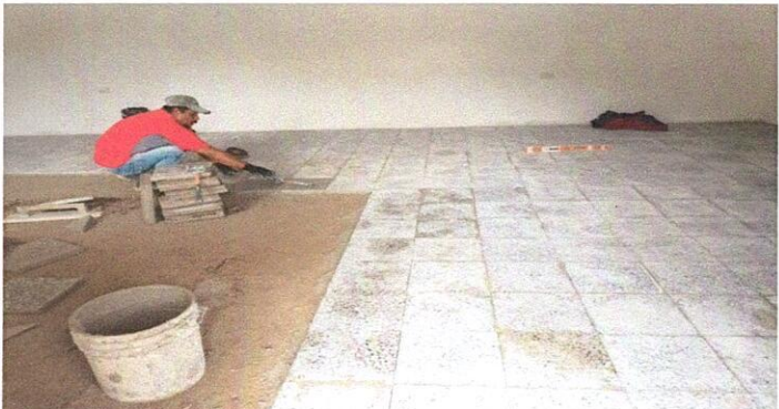
Foto 2: PISO: 6.5 Sustitución de piso de torta de concreto
