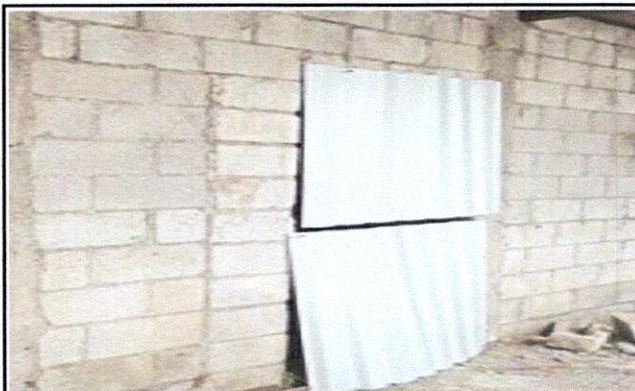
Foto 3: PUERTAS DE METAL 4.3. Sustitucion de puerta
