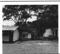
Foto 12: MÓDULOS DE AULAS SIN CANAL NI BAJADAS DE AGUA, MÓDULO DE COCINA NO TIENE PUERTA NI VENTANA, PINTURA EN MAL ESTADO, LAMINAS DAÑADAS
