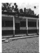
Foto 9: EL MÓDULO DE AULAS NO TIENE CANALES NI BAJADAS DE AGUA, HUMEDAD EN VIGAS DE CONCRETO, PINTURA DETERIORADA
