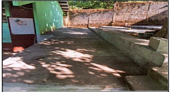
Foto 4: 6 PISO: 6.1 Reparación de piso de torta de concreto.
