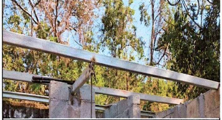
Foto 2: 1 CUBIERTA DE LÁMINA: 1.3 Sustitucion de elementos de fijación.
