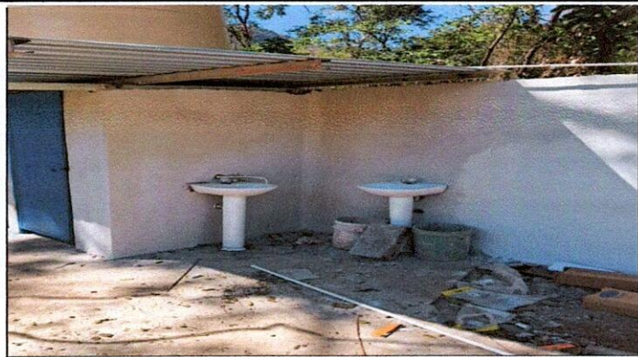
Foto7: 10 SERVICIOS SANITARIOS Y SUS ACCESORIOS. 10.5 Sustitución de lavamanos.
