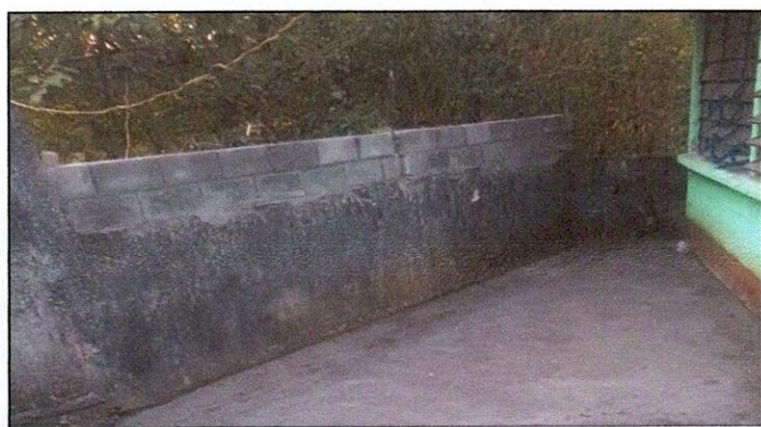
Foto 9: 15 Muros perimetrales: 15.1 Reparación de muro perimetral de block
