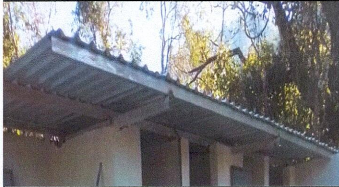
Foto 1: 1 CUBIERTA DE LÁMINA: 1.1 Sustitucion de lámina por lámina troquelada aluzinc calibre 26
