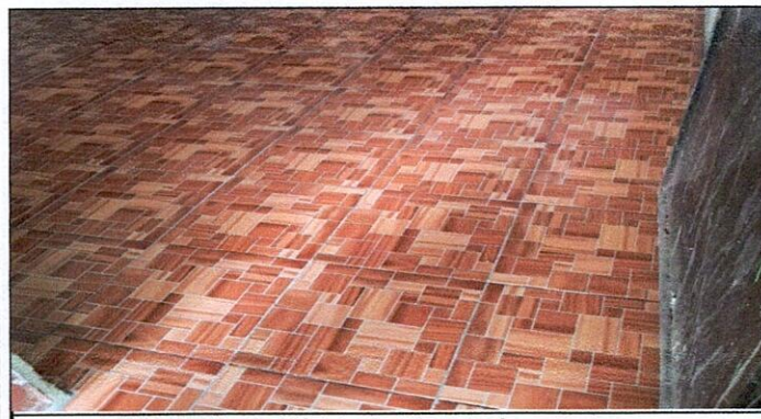
Foto 5: 6 PISO: 6.5 Sustitución de piso de torta de concreto
