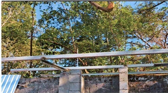
Foto 3: 2 ESTRUCTURA DE TECHO: 2.2 Sustitución de estructura de madera por metal.
