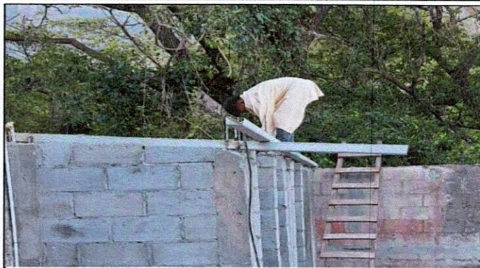
Foto 2: 1 CUBIERTA DE LÁMINA: 1.3 Sustitución de elementos de fijación.
