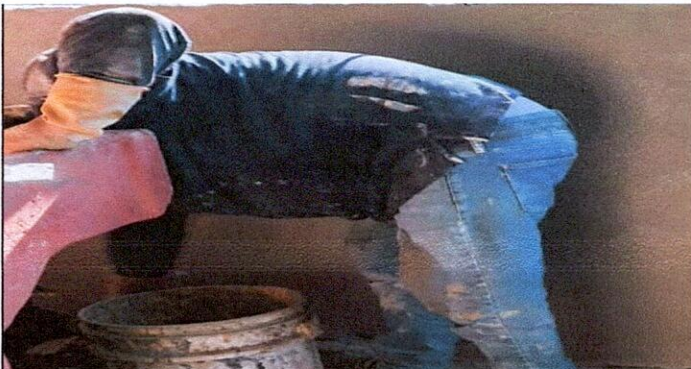
Foto 11: 20 REPARACIÓN DE COCINA: 20.10 Sustitución de pila de cemento de dos lavaderos
