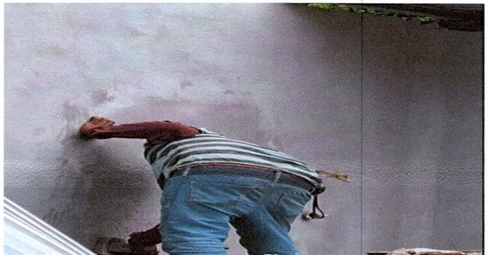
Foto 12: 21 Reparación de repello y cernido de paredes 21.2 cernido en muro.
