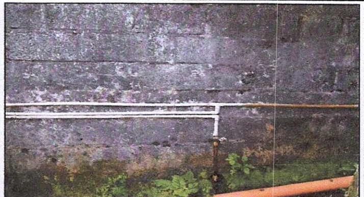
Foto 8: 14 REPARACIÓN DE RED DE DRENAJES Y RED DE AGUA POTABLE: 14.4 Sustitución de tubería pvc línea principal aguas pluviales
