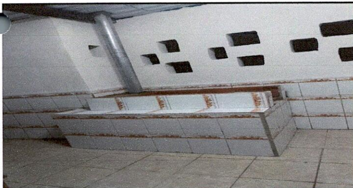
Foto 5: REPARACIÓN DE COCINA 20.1 Mantenimiento a estufa rural 20.5 Sustitución de chimenea de concreto 20.7 Instalación de azulejo en estufa rural
