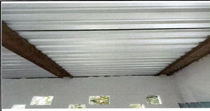
Foto 1: CUBIERTA DE LÁMINA 1.1 Sustitución de lámina por lámina troquelada aluzinc calibre 26
