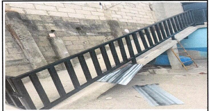
Foto 4: MANTENIMIENTO A BARANDAS 11.2 Sustitución de barandas de metal
