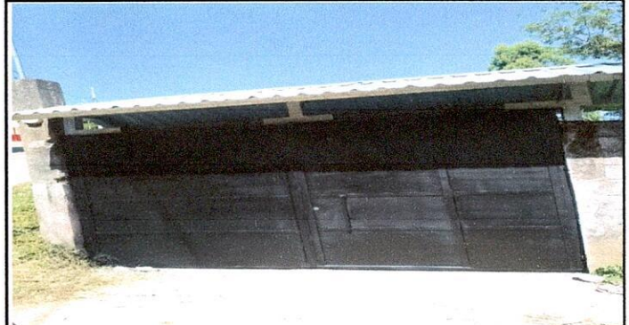
Foto 2: PUERTAS DE METAL 4.5 Sustitución de portón de metal
