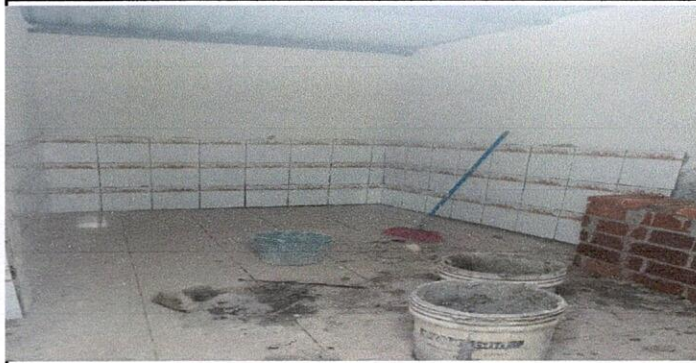
Foto 7: 21 REPARACIÓN DE CERNIDO Y EPELLO EN MURO (CUANDO APLIQUE): 21.2 Cernido en muro
